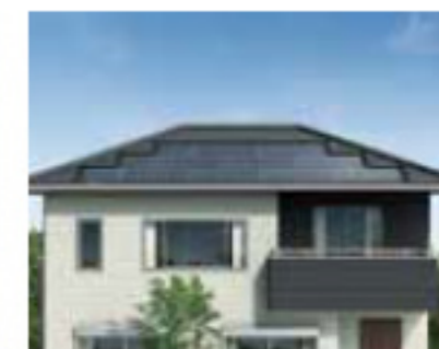
太陽光発電システム
